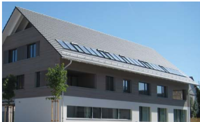
Kombination von Dachflächenfenstern und Solarmodulen (Beispiel Kleinandelfingen)
