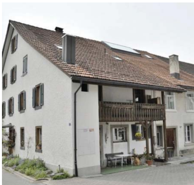
Von der Traufe überdeckter Balkon, Regenrinnen und Regenabläufe in Kupfer (Gizbüelweg 1, Wetzikerstrasse 59) (Bild: IBID)
