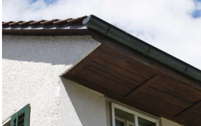
Typisches Ortgesimse und Dachuntersicht in Oberhittnau
