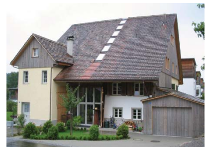
Vertikal verlaufendes Lichtband
