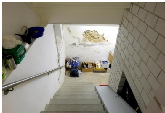
Abb. 20 Blick ins UG, rechts Kalksandsteinmauer vom Umbau 2004/05.
