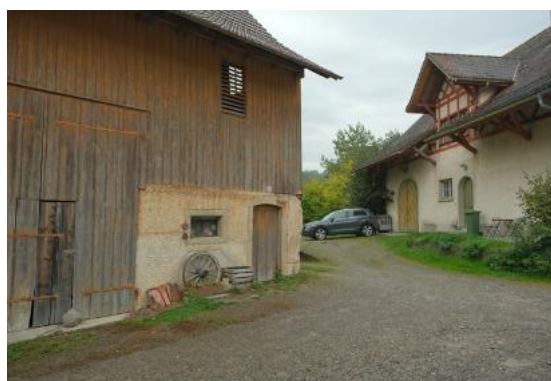
Abb. 10 Hofseitiger Bereich zwischen Scheune Oberdorfstrasse 97 und Dürstelenstrasse 73 (rechts), Blick Richtung Osten.
