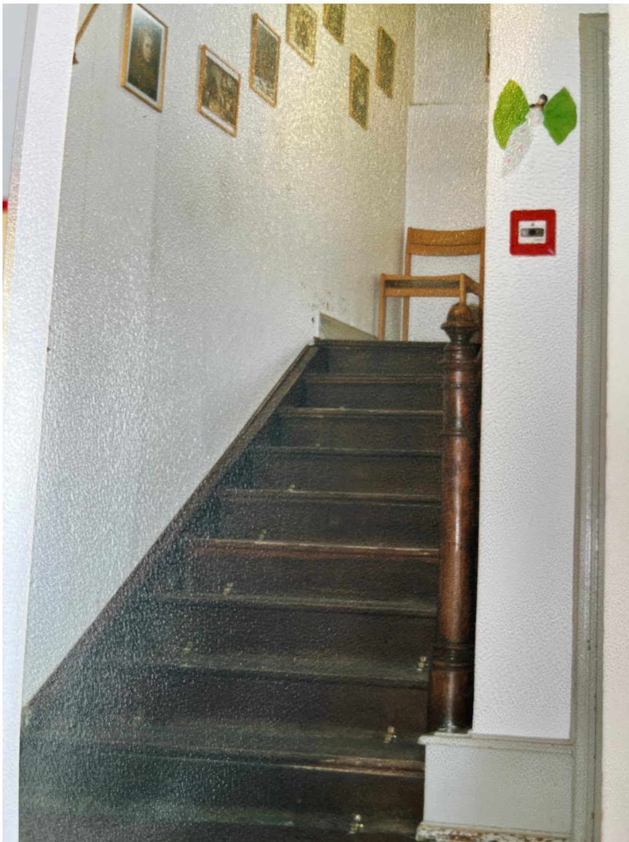
Fotodokumentation Renovation Villa Luppmenhof, R. Schmid, L. Forster, F. Forster, 2005 Chronikarchiv Hittnau
