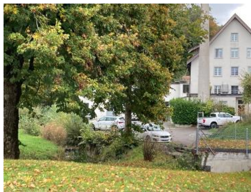
Abb. 12 Dürstelenstrasse, Blick Richtung Südosten, ehem. Spinnerei / Weberei mit Hochkamin und Luppmenbach.
