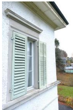
Abb. 11 Verdachung Fenster und Dachuntersicht, Südostfassade.
