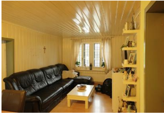
Abb. 27 DG, Blick Richtung Süden, Krallentäfer 1930er Jahre.
