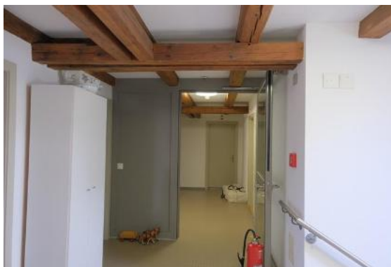
Abb. 34 DG, Mittelgang (2.1b), Blick Richtung Norden.
