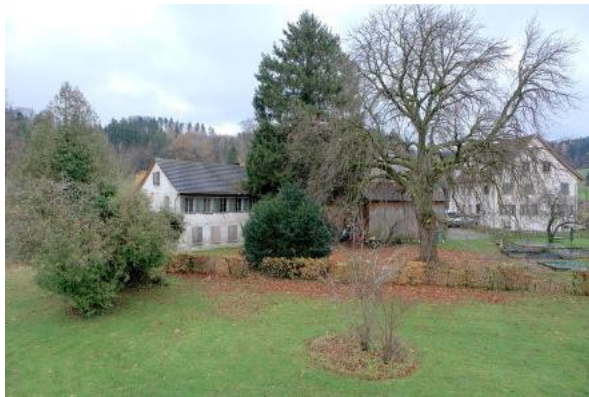
Abb. 4 Blick vom Balkon nach Süden, Gebäude Luppenareal, rechts ehem. Kosthaus.
