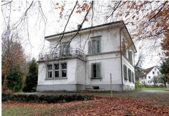
Abb. 12 Ansicht von Norden, Anbau von 1928.
