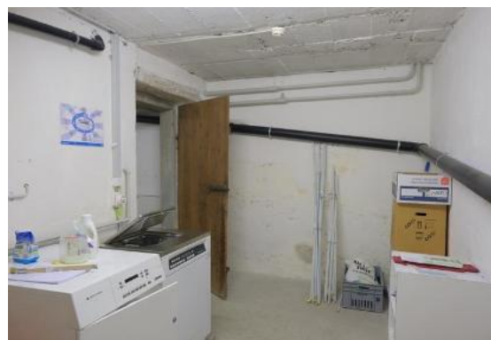
Abb. 21 UG, Waschküche (-1.5), Blick Richtung Westen. Tür mit Holzsturz und Sandsteingewände bauzeitlich.
