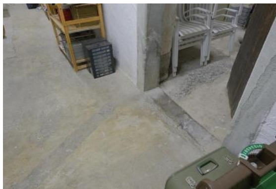
Abb. 22 UG, Mittelgang (-1.1), Zementboden jüngeren Datums.
