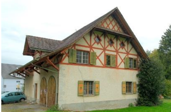
Abb. 21 Ansicht von Westen.
