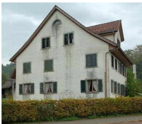
Abb. 15 Ansicht von Westen.
