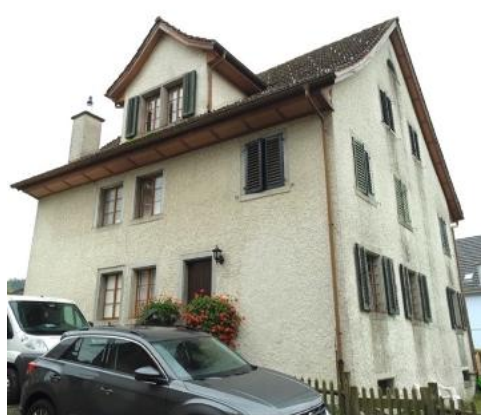
Abb. 18 Ansicht von Norden.
