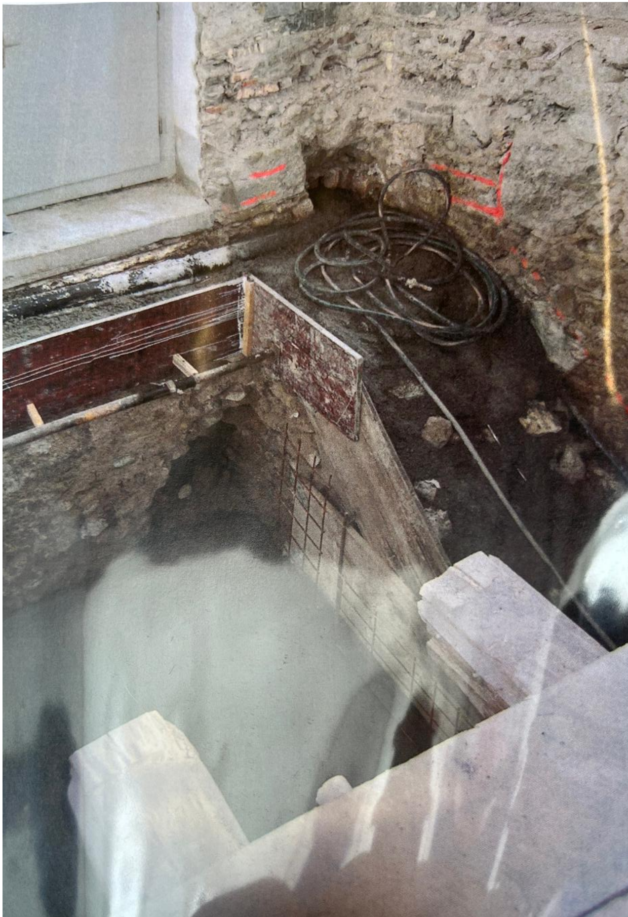
Fotodokumentation Renovation Villa Luppmenhof, R. Schmid, L. Forster, F. Forster, 2005 Chronikarchiv Hittnau
