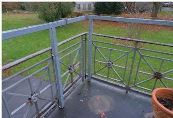
Abb. 10 Metallgeländer, Terrasse Südostfassade.
