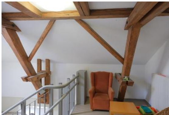
Abb. 32 DG, Treppenhaus, Blick Richtung Süden.
