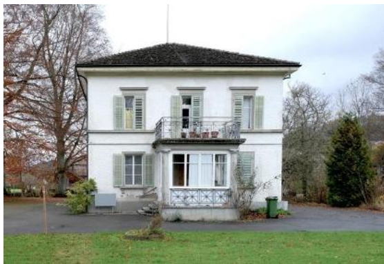
Abb. 8 Ansicht von Südosten, Anbau von 1920.
