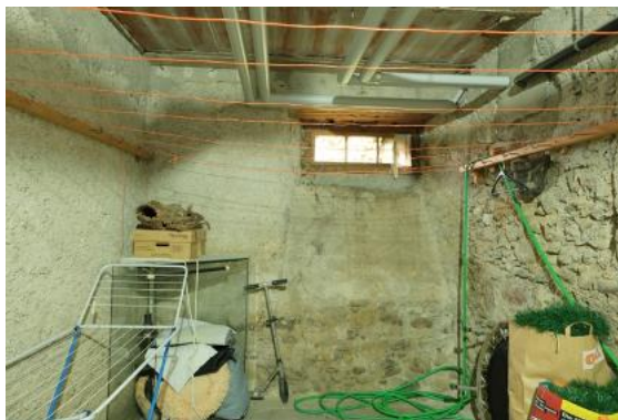
Abb. 23 UG, Kellerraum, Blick Richtung Westen. Hourdisdecke aus den 1970er Jahren.
