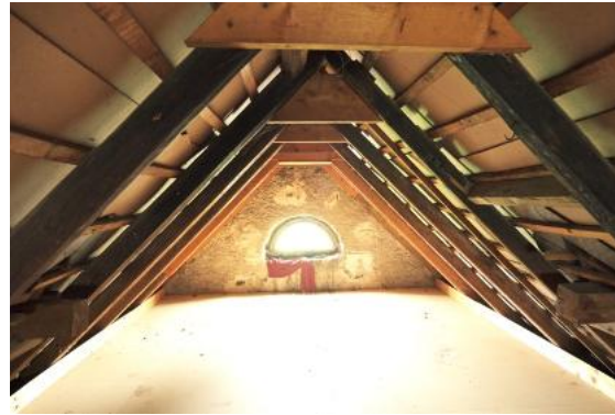
Abb. 28 Dachraum, bauzeitliches Sparrendach.
