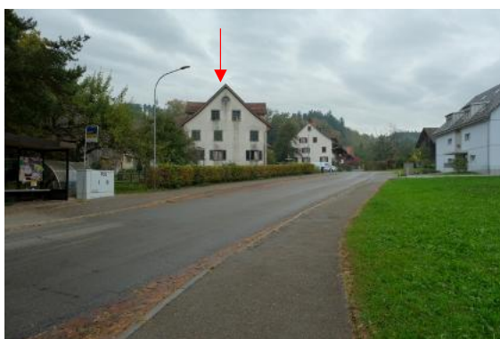
Abb. 9 Oberdorfstrasse, Blick Richtung Südosten, Oberdorfstrasse 95 rot markiert.
