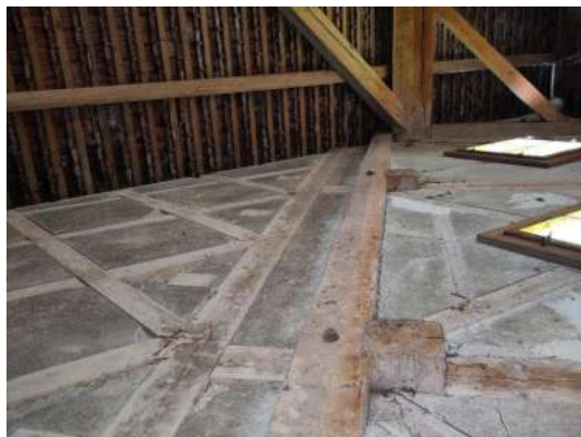
Abbildung 29 Riegelwand Giebelwand innen
