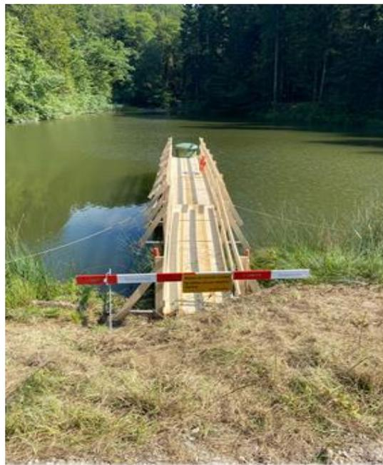
Der Staudamm unterer Luppenweiher wurde um 1876 erstellt und um 1925 durch eine Anschüttung rund 1 m erhöht. Seit 1925 wurde der Damm durch eine weitere Anschüttung verbreitert. Der Grundablass wurde im Jahr 2016 umgebaut und besteht seither aus einem PE-Rohr mit einem Durchmesser von 200 mm. Der Stauweiher besteht aus einem rund 9.5 m hohen homogenen Erdschüttdamm. Das Stauvolumen beträgt rund 32'000 m<sup>3</sup>.
